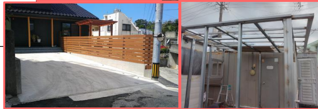
S様ご依頼 G市外構補修工事進捗状況
